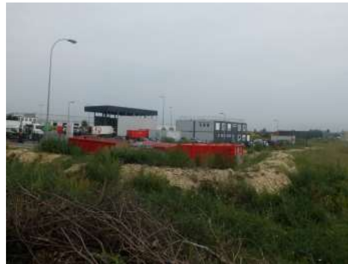
UN SITE EN COURS D'AMÉNAGEMENT (SOURCE TRANS-FAIRE, 2017)
