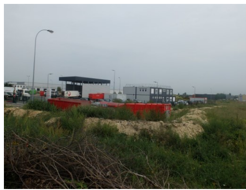
UN SITE EN COURS D'AMÉNAGEMENT (SOURCE TRANS-FAIRE, 2017)
