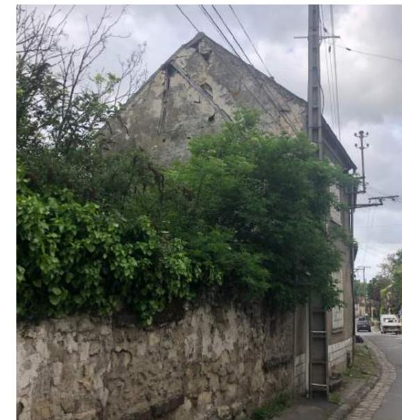
Angle rue Brûlée/rue de la Suef : un comble à surcroît réalisé en modifiant la pente de la toiture. La charpente originelle est conservée dans le comble. La tuile mécanique a remplacé la tuile plate.
