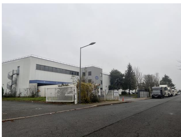
Rue Ferdinand de Lesseps, ZA du Pont de Brèche. Source : Verdi
